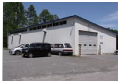
⑧ 端野剥き玉加工施設
