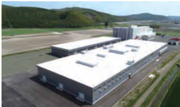
完成した施設
