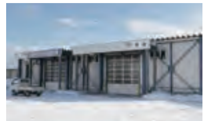
完成した訓子府車両整備工場
