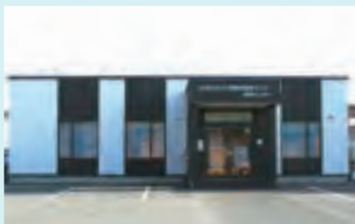
④訓子府整備工場事務所
