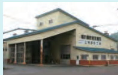
④ 温根湯豆類調製施設
