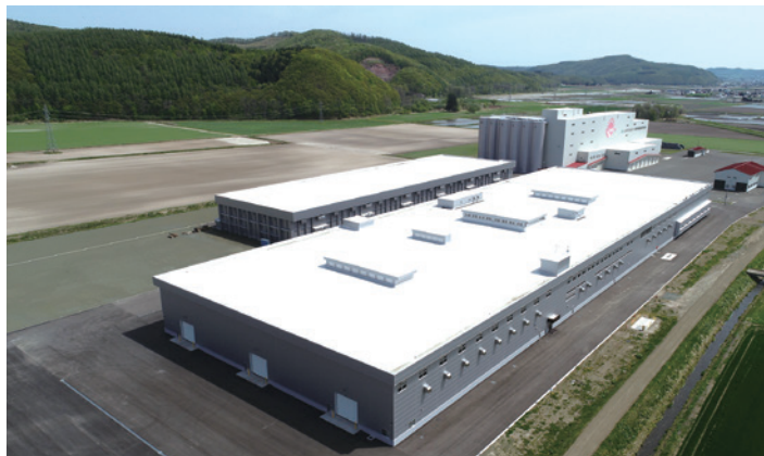
完成した施設
