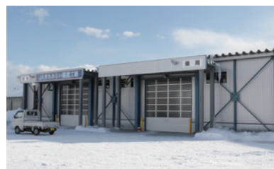
完成した訓子府車両整備工場
