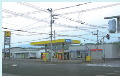
③ 温根湯給油所
