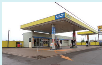
② 相内給油所
