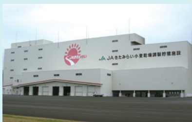
④ 西相内麦乾燥調製施設
