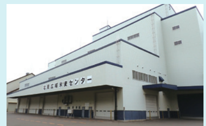
③ 広域米麦乾燥貯蔵施設
