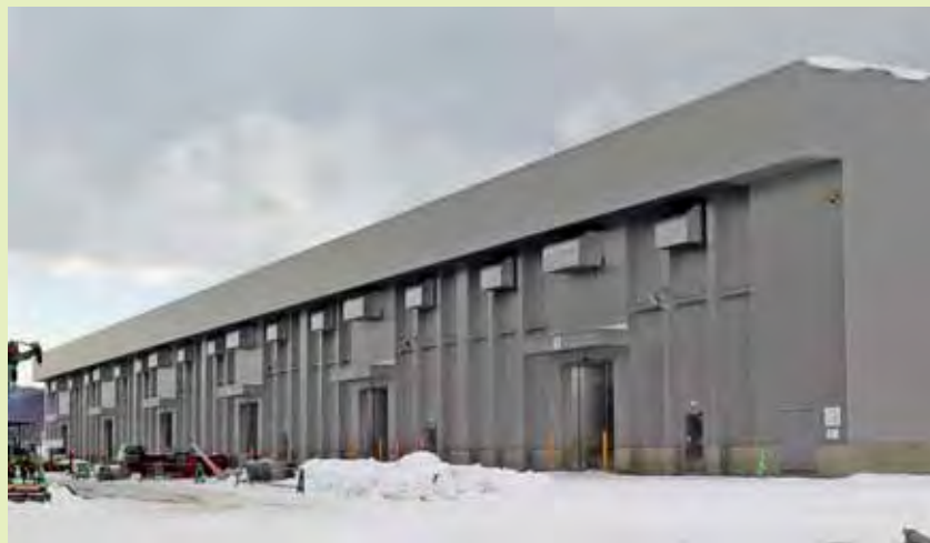
▲完成した「玉葱冷蔵貯蔵施設」
