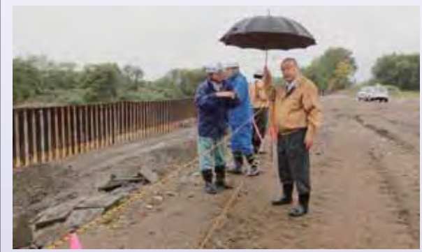
▲災害復旧工事現場を視察する西川組合長
