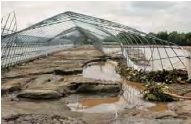
▲ハウスの損壊被害
