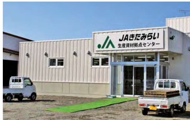
▲①新設の店舗兼事務所
