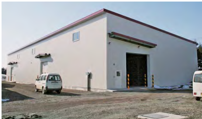
▲②新設の倉庫(農薬・肥料保管庫)
