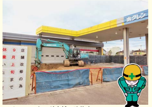
▲セルフスタンド店舗へ改修中
