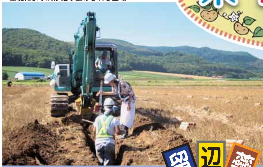
▼重機により溝が掘り進められる圃場
